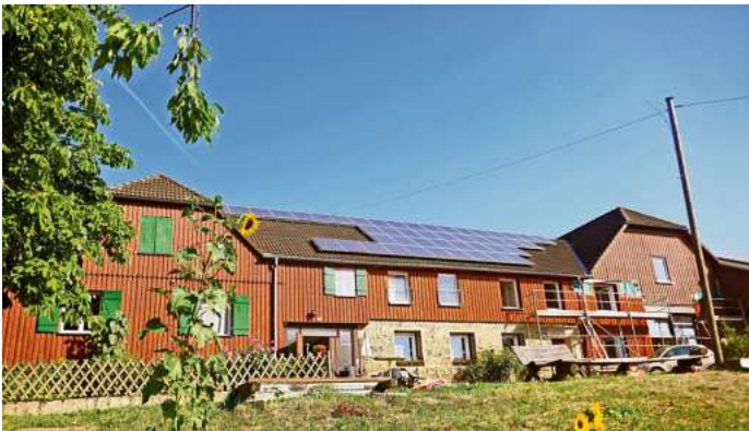
Im rechten Teil des Hofes Lattenberg entsteht die neue Außenwohngruppe des Kinderheims „Villa Sonnenheim“.
